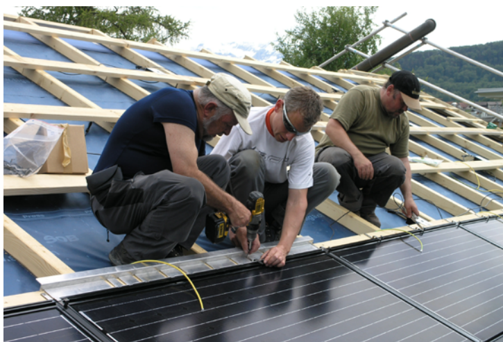
Abb. 01 — Bau einer Indach Solaranlage in Spiez. Die Selbstbauer montieren die Module. Foto: Syrril Eberhart •
