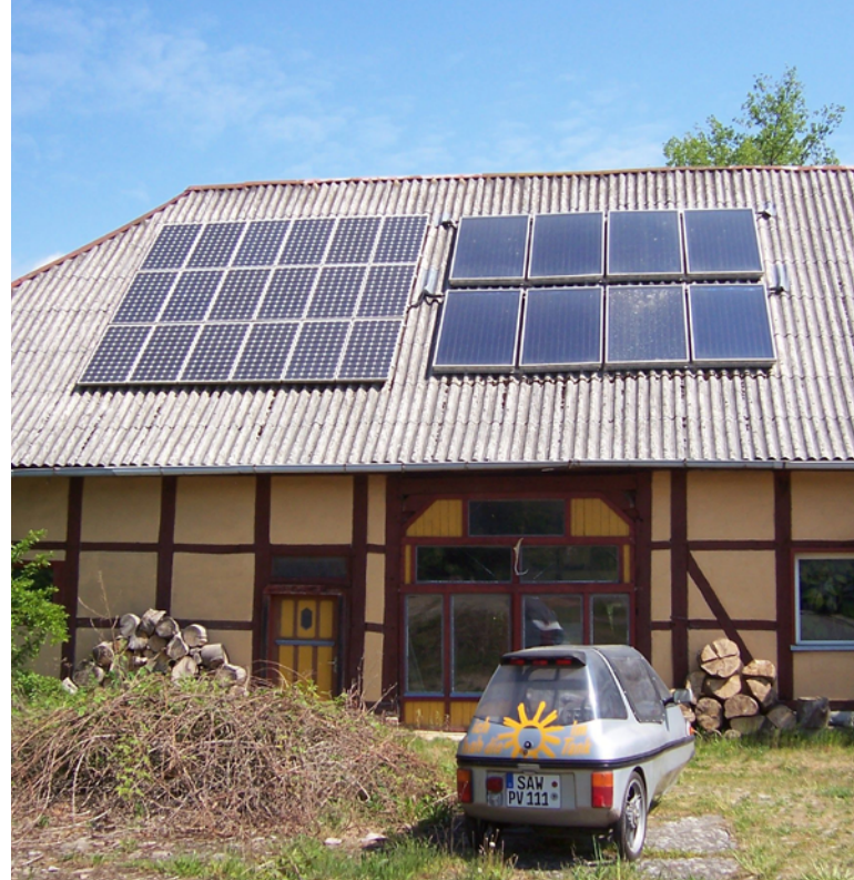
Abb. 2 — Haus von Christfried Lenz: Solarthermie- und Photovoltaik-Insulanlage. •
