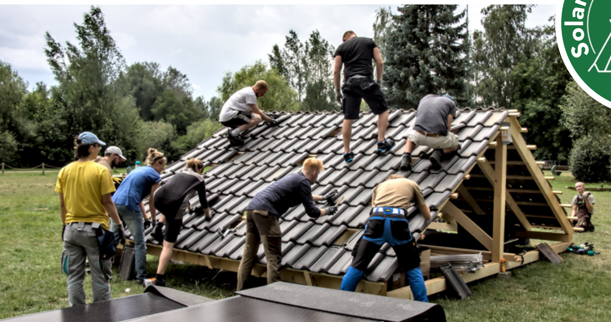
Abb 1 — Für das Solarcamp wird sogar ein Musterdach aufgebaut. Daran üben die Teilnehmenden Haken setzen und die Montage der Solarmodule. •
