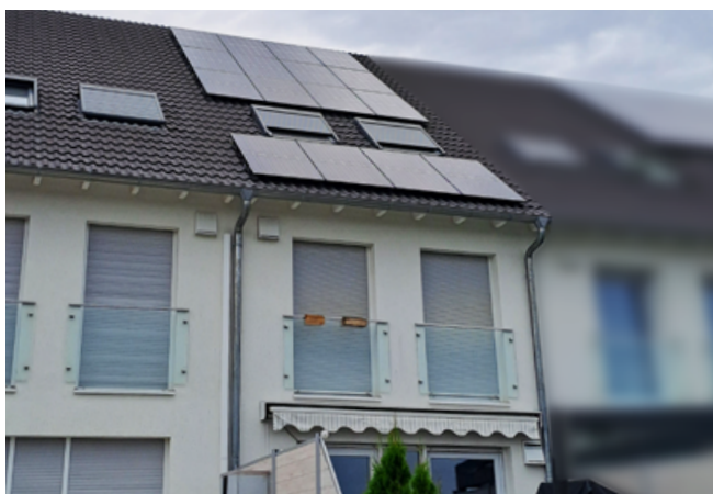
Abb 1 — Der nach Südwesten ausgerichtete Teil der PV-Anlage hat eine Peakleistung von 6,4 kW •
