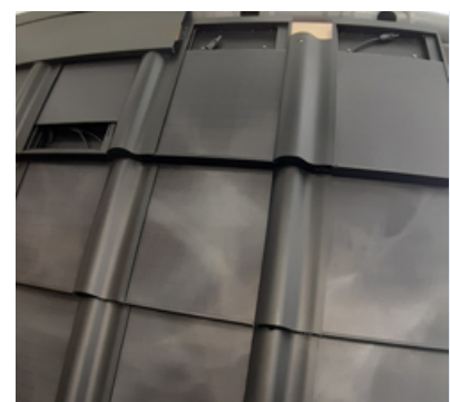
Abb 8 — Erkennen Sie die Solarzellen in diesen Dachziegeln? •
