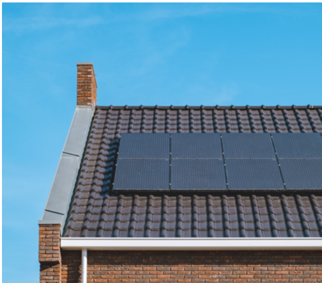
Abb 1 — Oft werden PV-Anlagen nur für den Eigenverbrauch dimensioniert. Dadurch werden Dachflächen nicht vollständig belegt. Stromverkauf an die Nachbarschaft könnte das ändern. •
