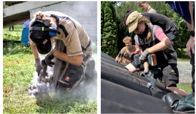
Abb 2 — Hand anlegen fürs Klimahandwerk: Dachziegel werden abgeflex, mit Akkuschrauber die Dachhaken festgeschraubt. •
