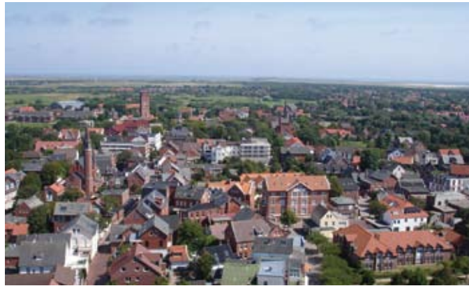
Überall warten Dächer und Fassaden auf Solaranlagen
