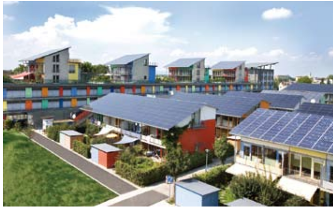
Solarsiedlung Freiburg: So sollte es überall aussehen! Foto: Rolf Disch, SolarArchitektur
