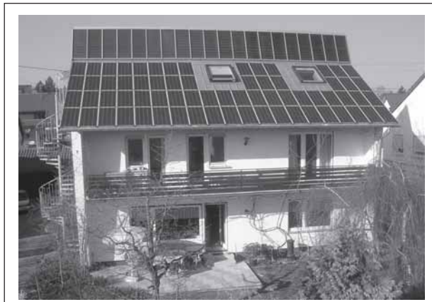
Solardach in Rottenburg Foto: Klaus-Jürgen Lehmann
