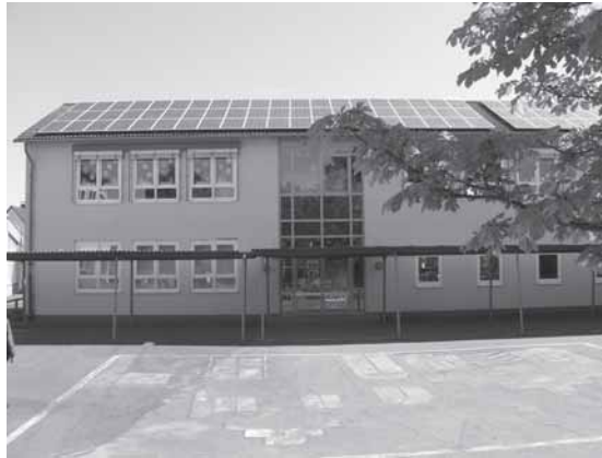
21,6 kWp-Solarstromanlage auf der Grundschule Niestetal-Sandershausen Foto: Landkreis Kassel
