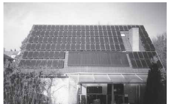
PV- und solarthermische Anlage Foto: Unbekannt
