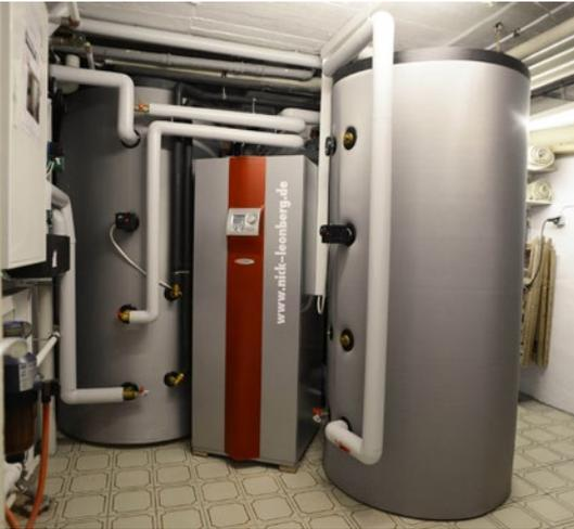
**Abb 7** — Warmwasserspeicher im Heizungskeller zur Speicherung der Wärme. Foto: Bundesverband Wärmepumpe (BWP) e.V. •
