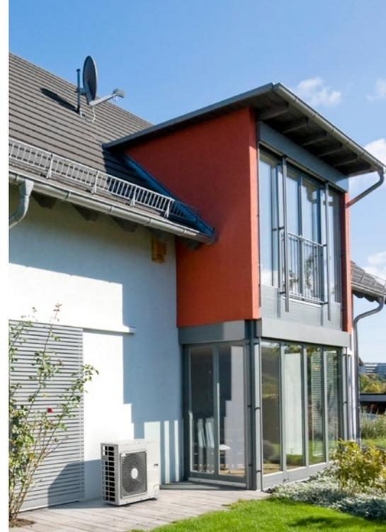
Abb 1 — Luft-Wasser-Wärmepumpe. Als Wärmequelle dient hier die Außenluft, die durch einen Ventilator angesogen wird. Foto: Bundesverband Wärmepumpe (BWP) e.V. •
