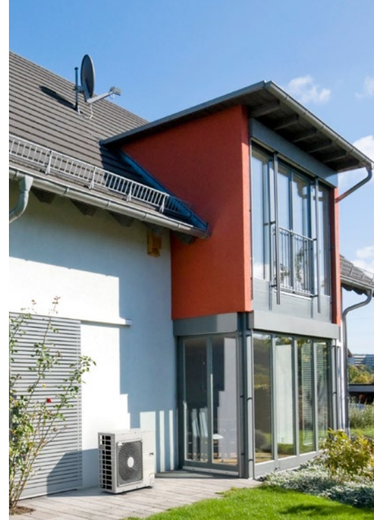
Abb 1 — Luft-Wasser-Wärmepumpe. Als Wärmequelle dient hier die Außenluft, die durch einen Ventilator angesogen wird. Foto: Bundesverband Wärmepumpe (BWP) e.V. •
