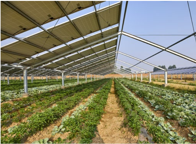
Abb 02 — PV in der Landwirtschaft erzeugt nicht nur Strom. Sie sorgt zusätzlich für Verschattung, Hagel- oder Windschutz, erhält fruchtbare Ackerfläche und ist ein weiteres finanzielles Standbein einer regionalen Landwirtschaft. •
