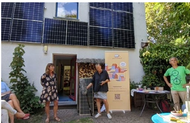
Abb 1 — Solar-Botschafter Peter erklärt seinen Nachbar:innen die Funktionsweise den Aufbau seiner PV-Anlage •
