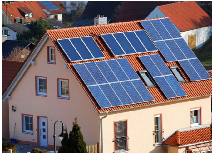
Abb 3 — Auf den ersten Blick optisch recht ähnlich: Solarthermie-Kollektoren und Photovoltaik-Module •
