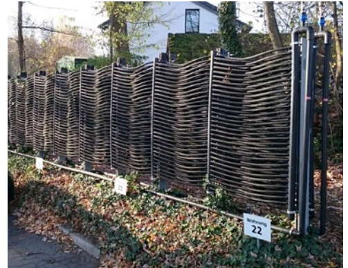
Foto: Wärmepumpen-Zaun. Foto: E.Waffenschmidt
