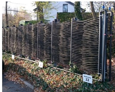
Foto: Wärmepumpen-Zaun. Foto: E.Waffenschmidt
