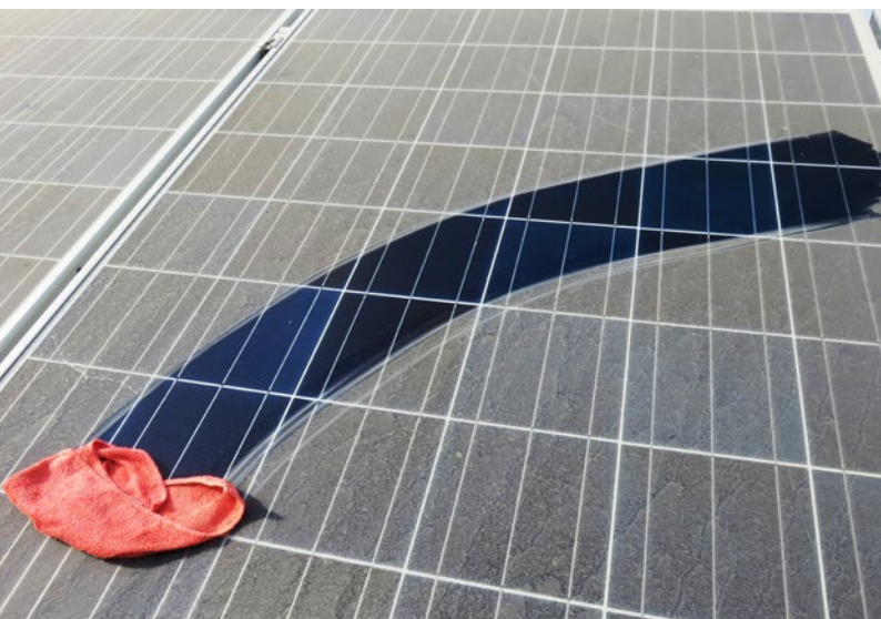
Abb 1 — Solarmodule können zum Beispiel durch Pollenstaub verschmutzt werden. Der meiste Dreck geht durch den Regen wieder weg •
