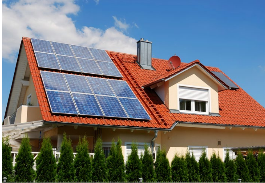
Abb 2 — Photovoltaik-Anlage mit horizontalem Wartungsgang. Bei nötigen Kontrollen oder Reparaturen können Solarteure:innen so alle Paneele gut erreichen. Bei den meisten Anlagen werden Wartungsgänge nicht berücksichtigt. •
