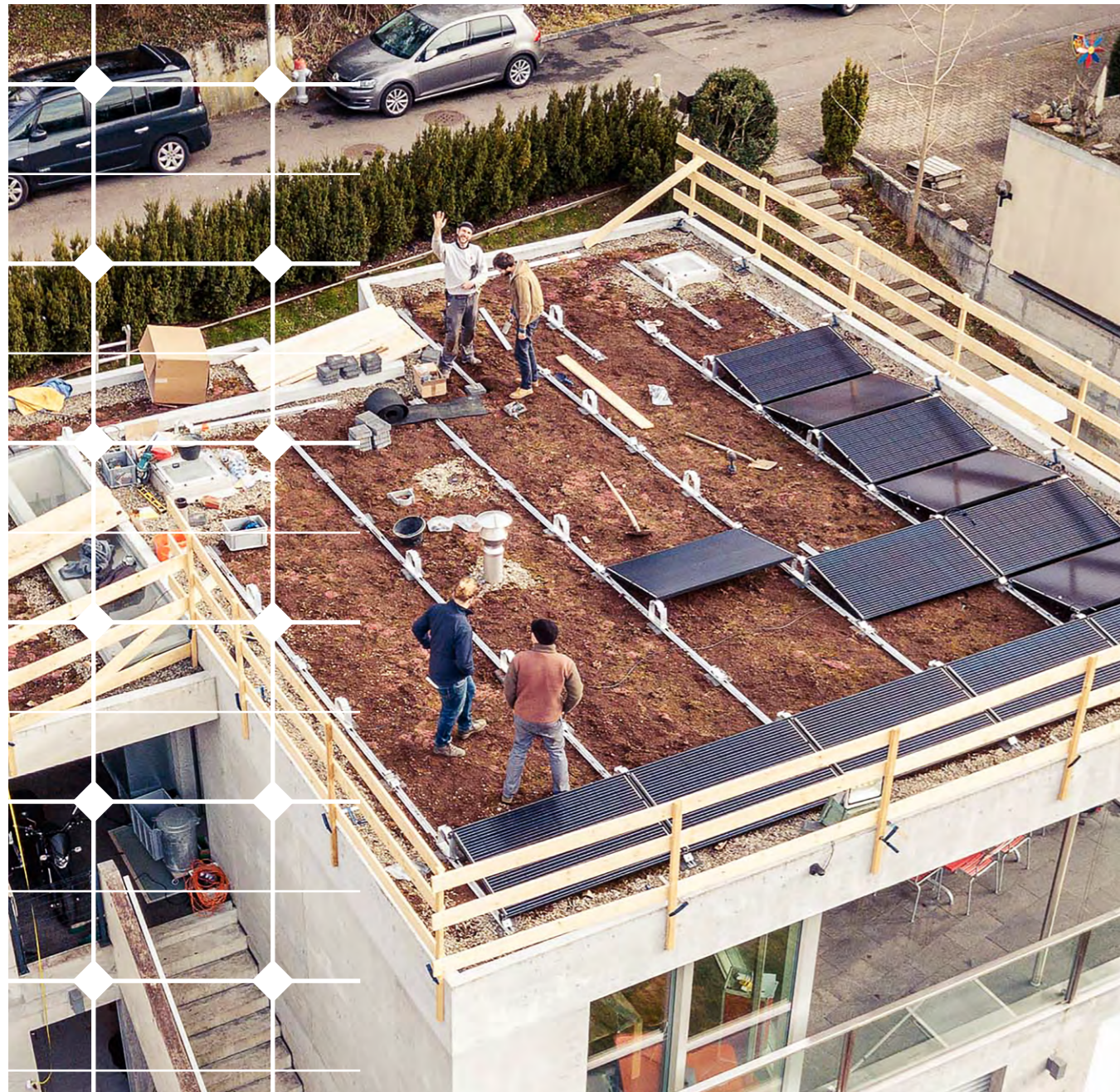
— Bau einer Solaranlage in Münchenstein BL mit der Energiewendegenossenschaft Basel (EWG Basel). Foto: EWG Basel, Pascal Städeli
