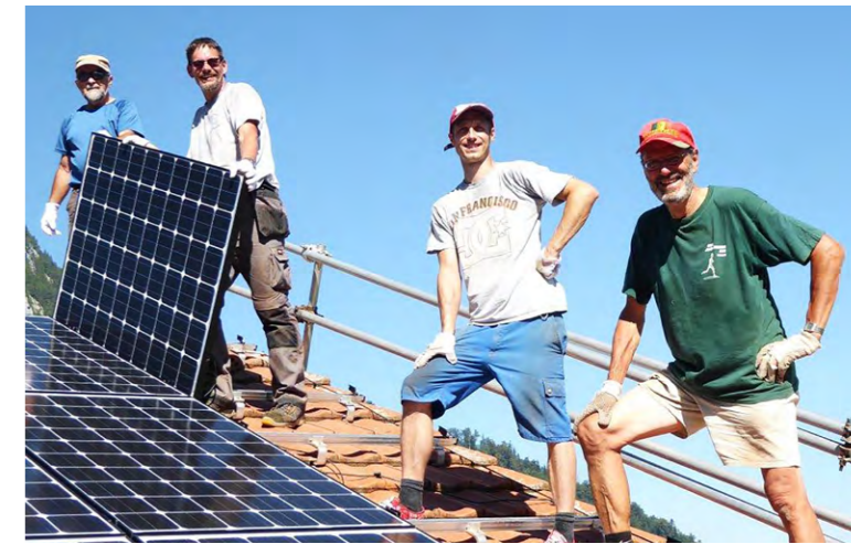
— Bau einer Aufdach Solaranlage in Wimmis.
