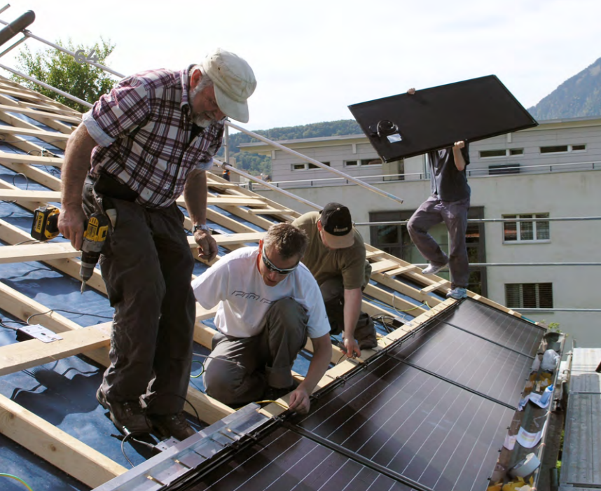
— Bau einer Indach Solaranlage in Spiez. Die Selbstbauer montieren die Module. •
