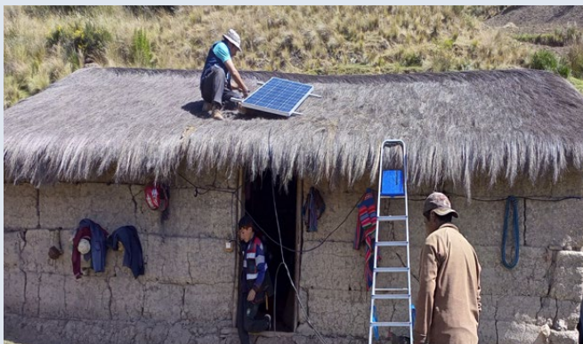
Abb 1 — Aufbau und Anschluss der gespendeten Photovoltaik-Module in Bolivien •
