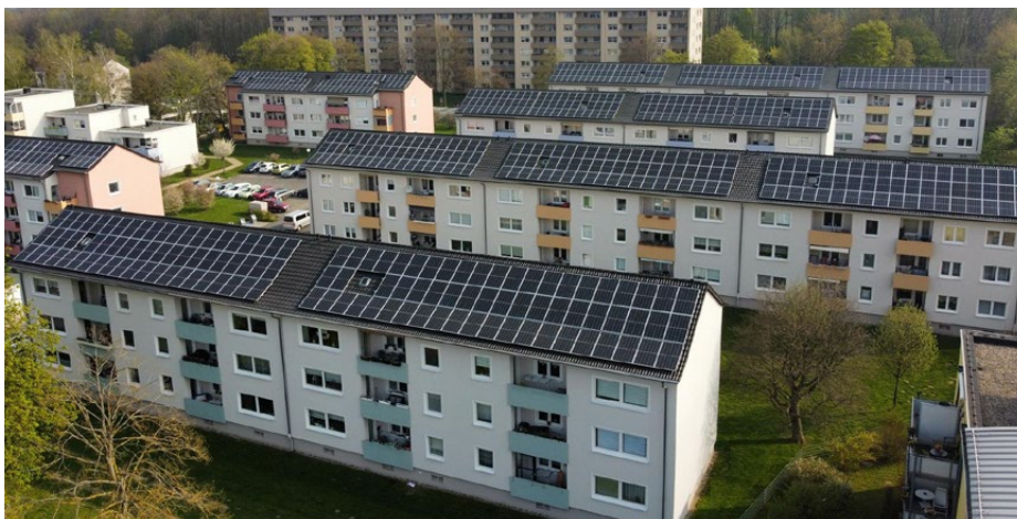
Abb 1 — Auf dem Bild sind sechs der inzwischen rund 130 Photovoltaikanlagen der BEG-58 zu sehen. Vier davon auf Doppelhaushälften und zwei davon auf Reihenhäusern mit je drei Gebäuden. Je Doppelhaushälfte/Reihenhauses wurde eine PV-Anlage errichtet. Die Anlagengröße variiert von 30 kWp bis 61 kWp. Insgesamt sind 273 kWp installiert. Foto: BEG-58 •
