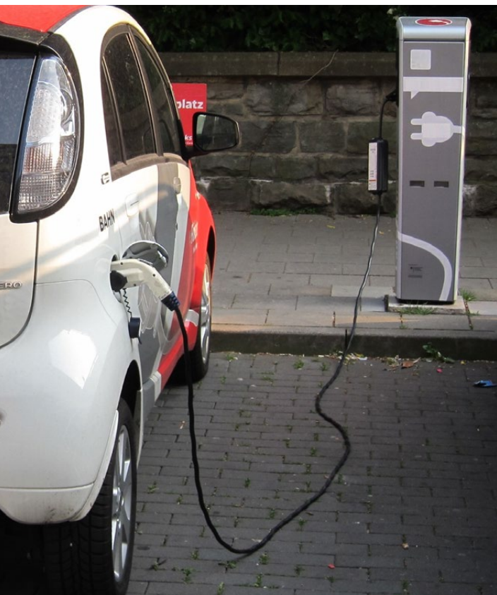
Abb 1 — Ladestation mit Elektrofahrzeug. Foto: E. Waffenschmidt •
