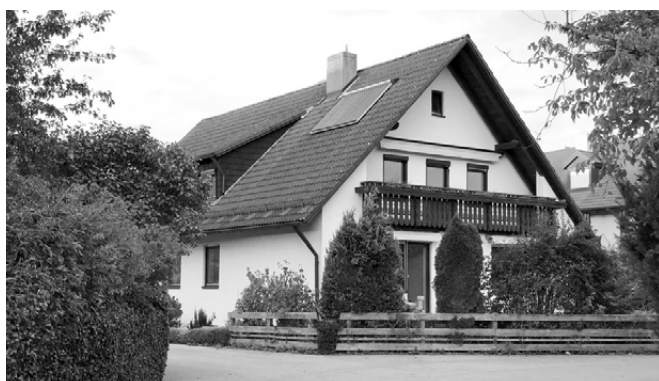
Abb 2 — Familienhaus aus den 80er Jahren vor dem Umbau •
