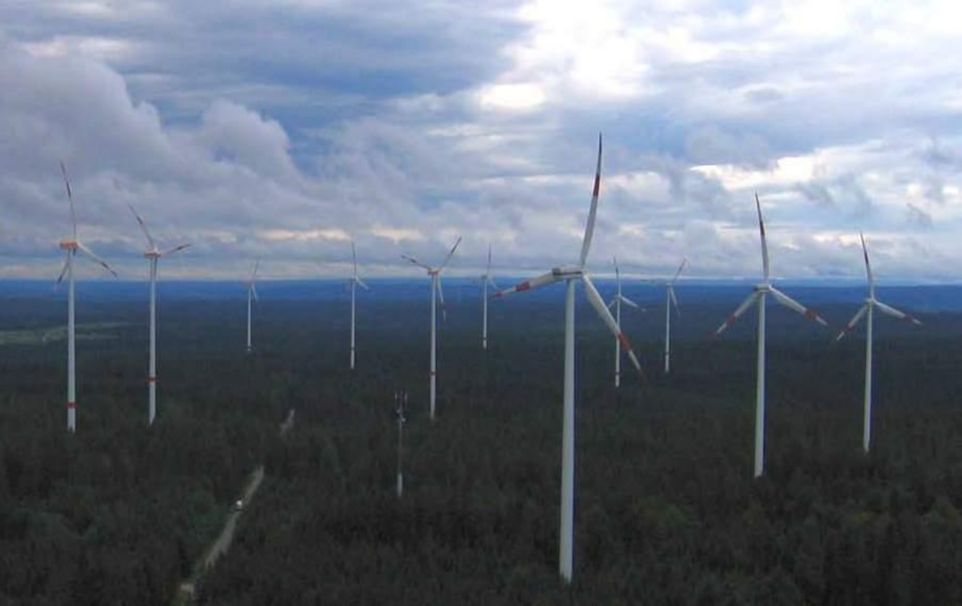
Windpark Nordschwarzwald, größter Windpark von Ba-Wü. An B294 zwischen Pforzheim und Freudenstadt 14 Anlagen je 2 MW
