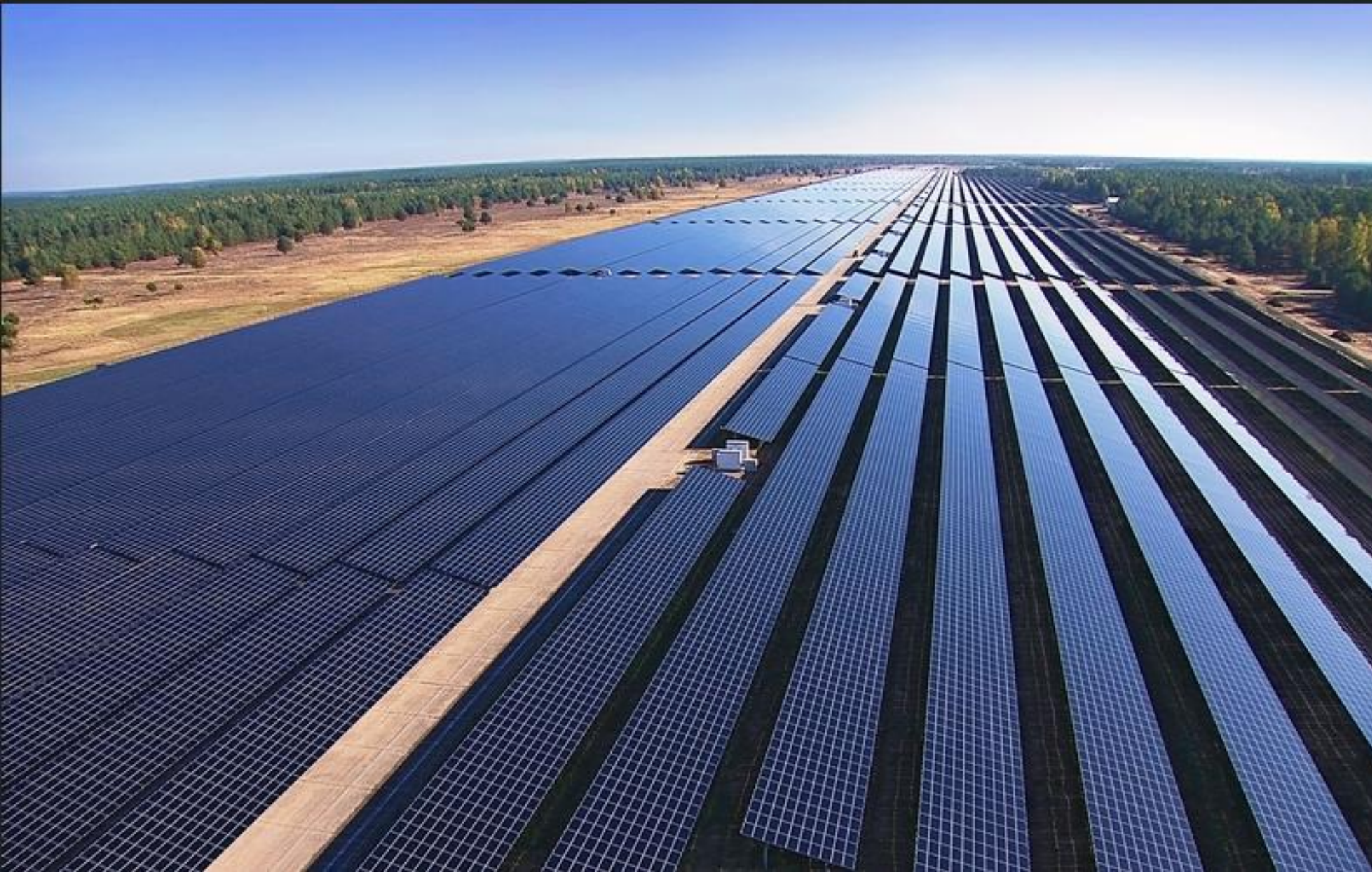
Solarkraftwerk Templin 128 Mwpeak Untypisches Beispiel für Solarenergie
