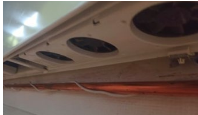
Abb 4 — Optisch und akustisch unauffällig: Mit Lüftern leistungsgesteigerter Heizkörper •
