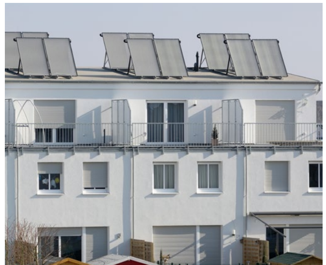
Abb 2 — Mehrfamilienhäuser mit Solarthermie-Kollektoren auf dem Dach. •
