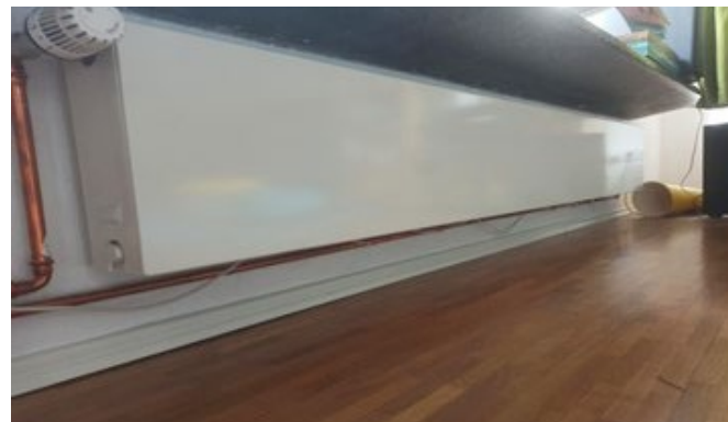
Abb 3 — Flachheizkörper Typ 22 •
