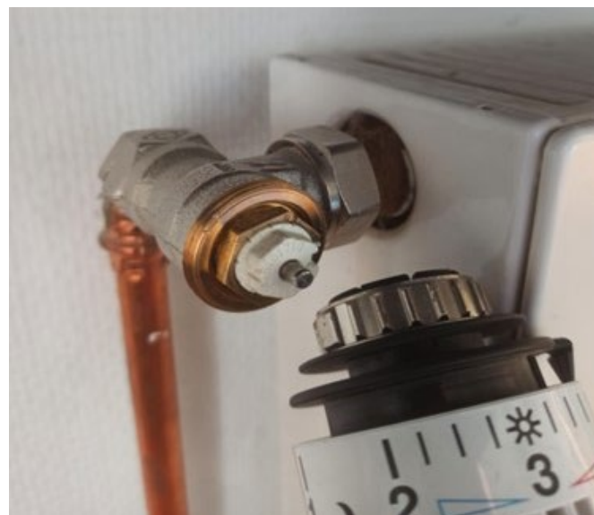
Abb 5 — Feineinstellung der Heizkörper am Ventileinsatz •
