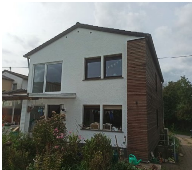
Abb 2 — Gesamtansicht: Alter Bau neu beheizt - auch ohne Vollsanierung •
