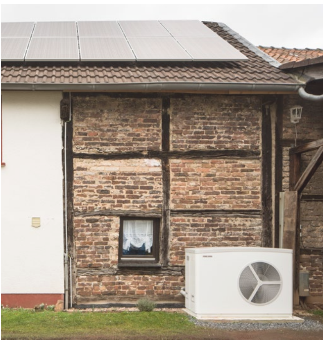
Abb 1 — Ein Duo aus etwas älteren Tagen: Die Kombi Wärmepumpe und PV ist längst etabliert. Foto: C. Stiebel •
