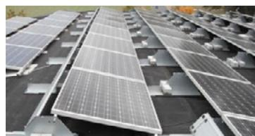
**Abb 03**— Nach Süden ausgerichtete PV-Anlage. Um Verschattung zu vermeiden, muss ausreichend Abstand zwischen den Modulreihen gehalten werden. © Ulrich Böke •
