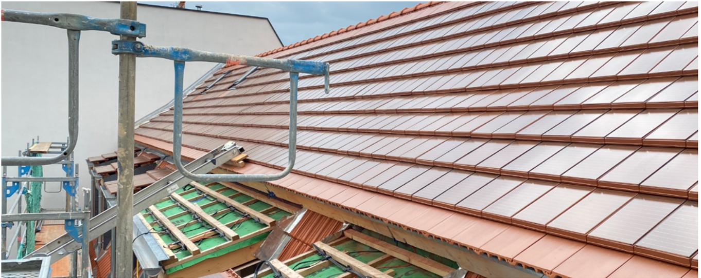
**Abb 1** — Installation von Solardachziegeln auf einem denkmalgeschützten Mehrfamilienhaus in Heidelberg: Der Betreiber kämpft dafür, dass die Gemeinschaftliche Gebäudeversorgung für die Mieter:innen umgesetzt wird. Foto: A. Kühn •
