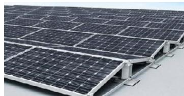
**Abb 04** — Kombinierte Ost-West-Ausrichtung. Auf der selben Dachfläche können so mehr Module untergebracht werden. © Ulrich Böke •
