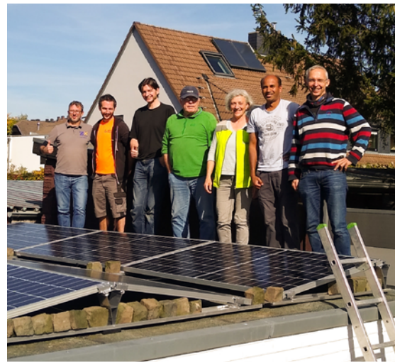
Abb 7 — Die erste montierte PV-Anlage der Aachener Selbstbaugruppe ist fertig. •
