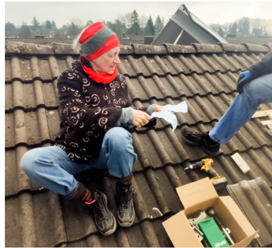
Abb 6 — Dachhaken setzen ist mühselig, führt aber kein Weg dran vorbei. •
