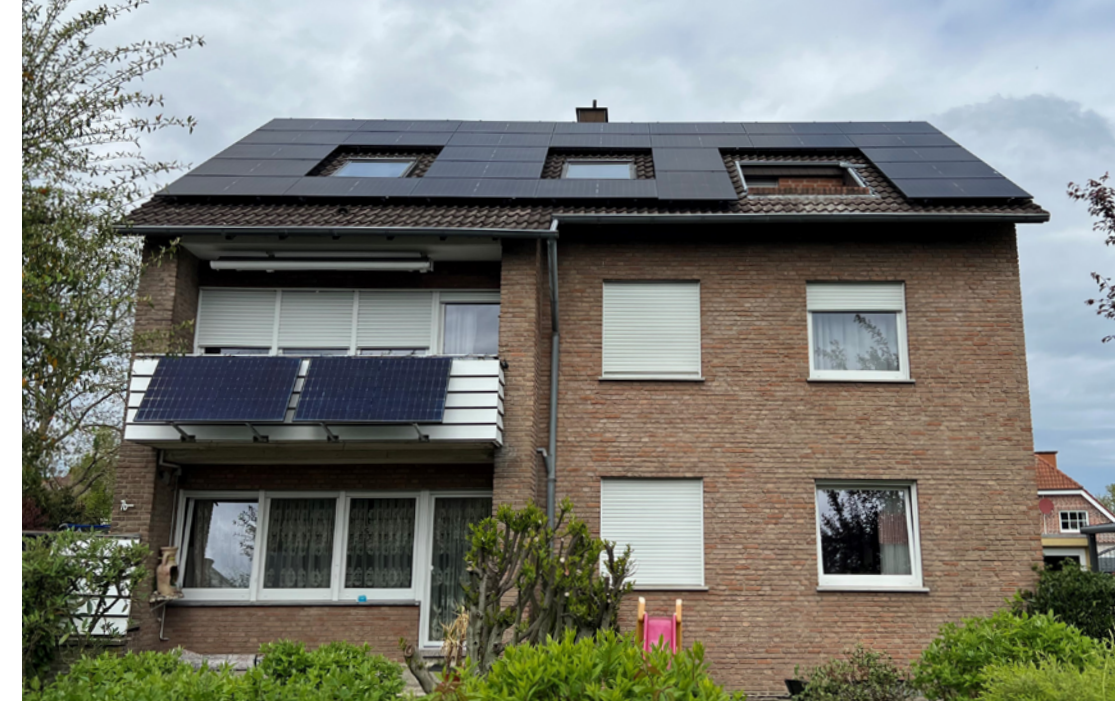
Abb 2 — Ein dynamischer Verteilungsschlüssel sorgt dafür, dass der Strom vom eigenen Dach flexibel und bedarfsorientiert auf die Mietparteien verteilt wird. © David Scherwitz, Halle •
