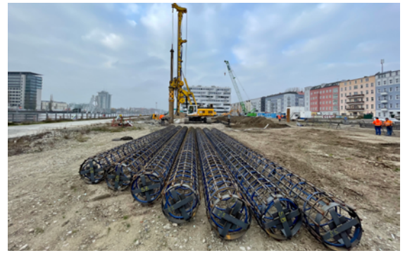
Abb 2 — Aktivierte Bohrpfähle • Foto: Tobias Schulze
