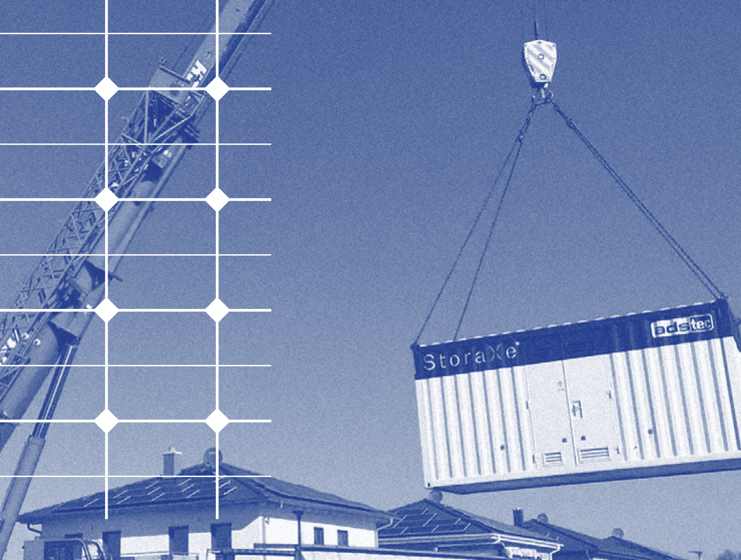
Abb 1 – Anlieferung eines Quartierspeicher-Containers in einem Neubaugebiet • Foto: ads-tec Energy
